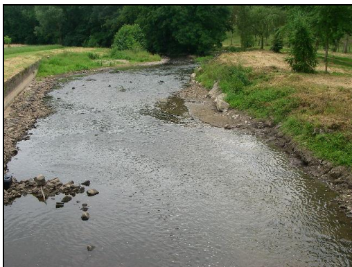
Amont passerelle, juillet 2013
