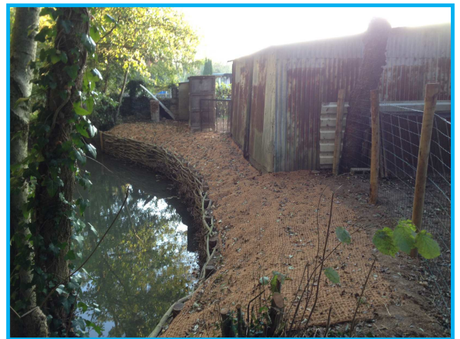
Travaux de restauration de berge en fascinage de saule à ST GEORGES SUR ERVE
