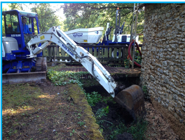
Nettoyage du canal d'amenée du Moulin de Rochebrault à ST PIERRE SUR ERVE/THORIGNE EN CHARNIE
