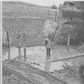
Une fascine de sautes sur l'Erve et l'installation d'un abreuvoir indirect sur le bord de l'Erve, à Saint-Georges-sur-Erve.
