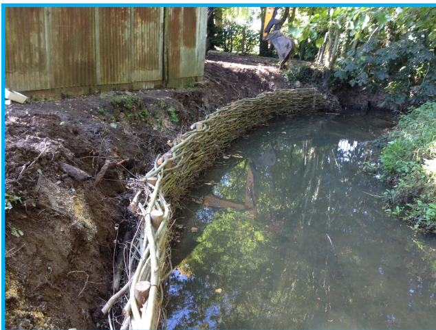
Travaux de restauration de berge en fascinage de saule à ST GEORGES SUR ERVE
