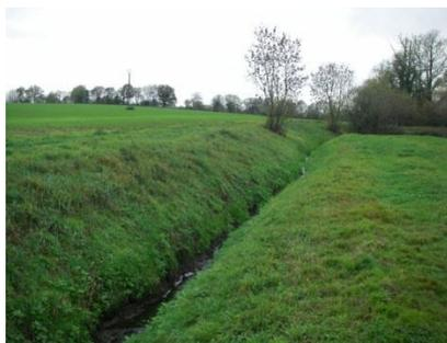
Le profil en travers du cours d'eau est modifié pour augmenter sa capacité hydraulique
